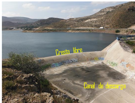
Figura 6. Vertedor de cresta libre, presa Gonzalo N. Santos, S.L.P.
