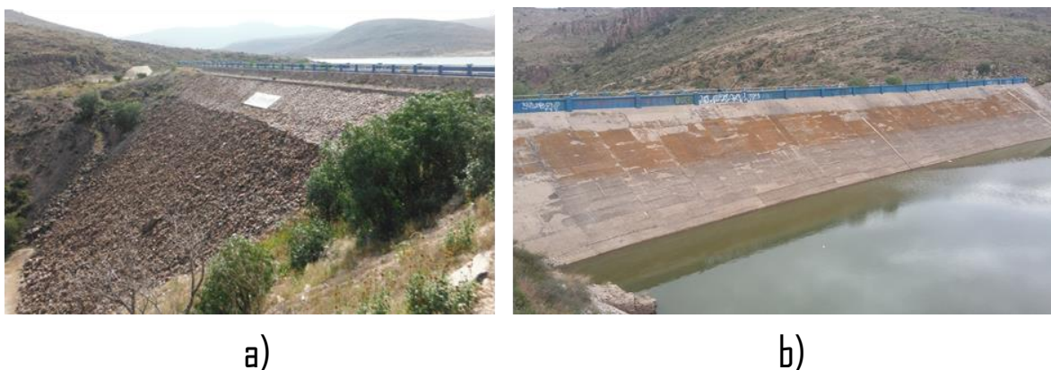
Figura 4. Cortina de la presa Gonzalo N. Santos. a) Aguas abajo (tipo enrocamiento): b) Aguas arriba (cara de concreto)
