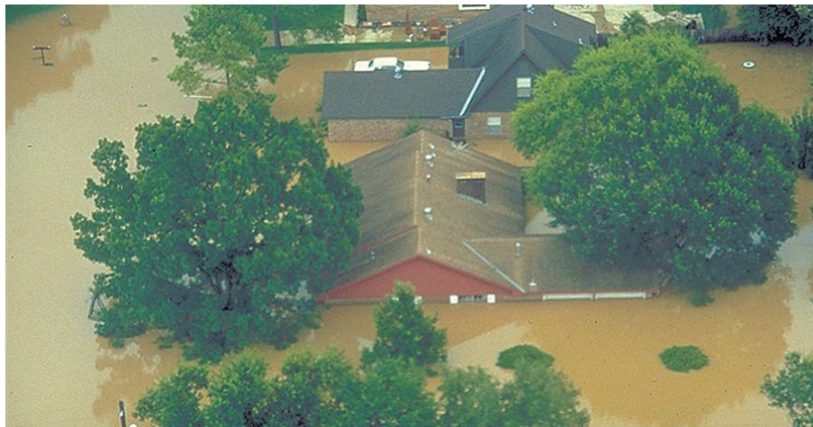
Fig. 3.3. Inundación en viviendas afectadas por subsidencia en Houston Texas, durante una tormenta en junio de 1989. Tomada de Galloway et al. (2008).
