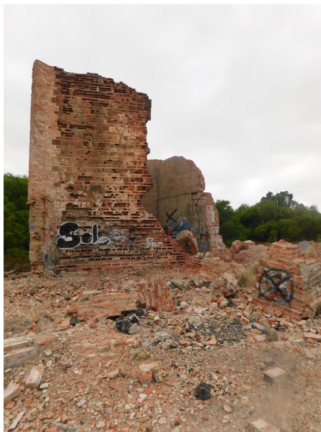
Figura 4 Restos de la chimenea principal de la antigua fundición de Pb en Matehuala. Se observan los restos de la construcción altamente contaminados por As, Pb, Cd, Cu y Zn en contacto con el suelo.
