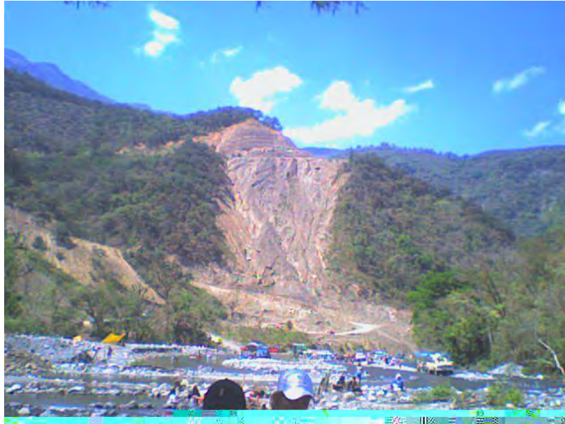
Figura 16. Punto 7. Deslizamiento de ladera ubicado en Rio Tlacuilo, al Oeste de Tlapehuala, coordenada: 20°18'58.01"N 98° 2'35.50"O. Tomado por Ángel en (22-03-2008).
