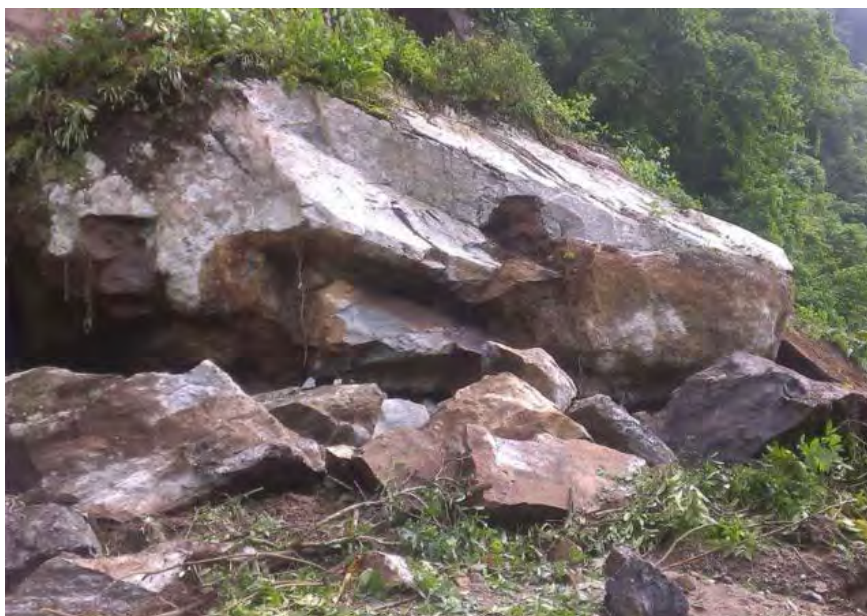
Figura 25 .Genaro Zepeda (15/06/2015). Caídas de rocas en la carretera Pezmatlán-Mazatepec, dejando incomunicadas siete localidades en la zona de Tlatlauquitepec, ubicada en la Sierra Norte de Puebla.
