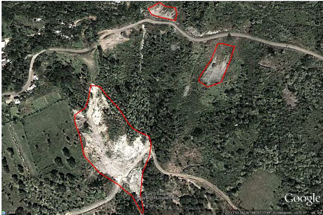
Figura 5. Punto 12. Deslizamiento de ladera, Carretera rumbo a Tlacruz-Pahuatlán- Cuaunetla-Tlacuilotepec, coordenadas: 20°17'51.41"N, 98°07'34.28"W.
