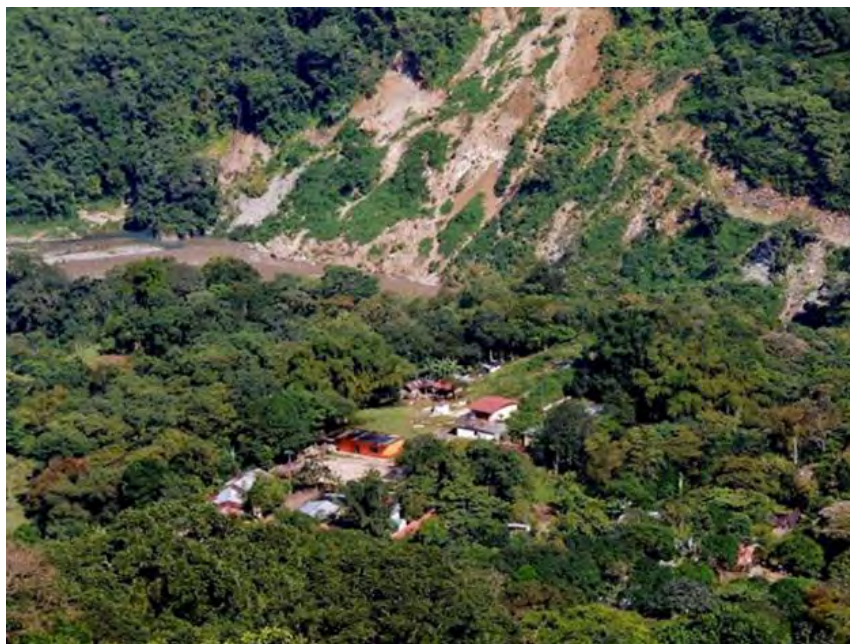
Figura 8. Punto1. Deslizamiento de ladera, ruta Tuxpan-Veracruz, coordenadas: 20^{\circ}19'51.79''\text{N} 97^{\circ}57'33.95''\text{O} . Tomado por Sergio Arce (06-10-2014).
