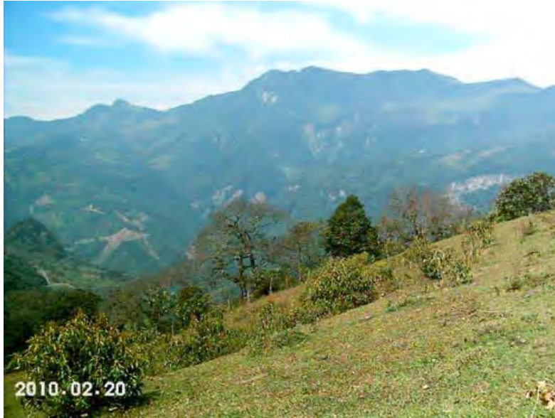
Figura 9. Punto 2. Cortes de laderas, posible inestabilidad de taludes, ubicado al noreste de Tlapehuala, con coordenadas: 20^{\circ}19'3.50''N 98^{\circ}0'31.15''O . Tomado por JRW&P (20-02-2010)
