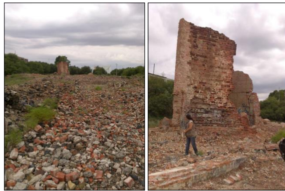
Figura 16. Fotografías actuales del terreno de la antigua planta de fundición de Matehuala, San Luis Potosí. Se observa la demolición del sitio y el abandono del escombros en el sitio (Colección personal).
