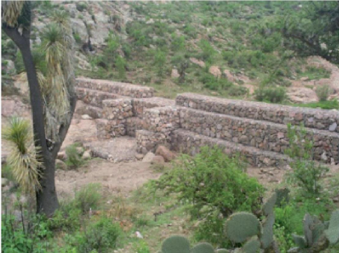
Figura 1.2: Presa tipo gavión tomada de SAGARPA (2009).
