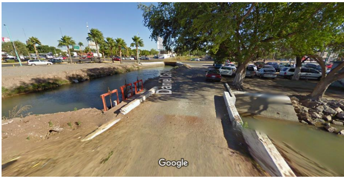
Figura 12. Compuertas sobre el Canal Sublateral 23+700 (13) que regulan el flujo de entrada en el Canal Ramal 2+700. Obtenida de Street View de Google Maps (diciembre de 2009).
